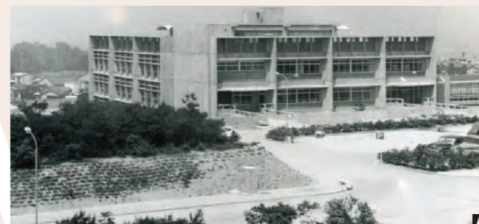
本部棟側から見た図書館。エントランス前は駐車場だった。
