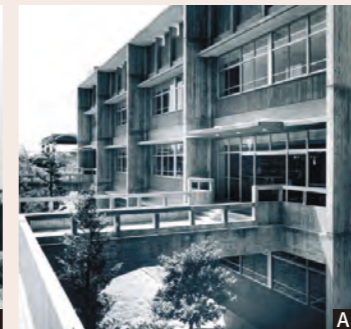
1980年の増築前は、高低差のためにエントランスには橋が架っていた。
