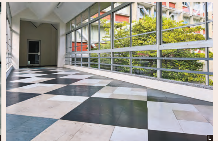
図書館と第1研究室棟をつなぐ渡り廊下。床に配された菱柄のデザインは当時のままである。
