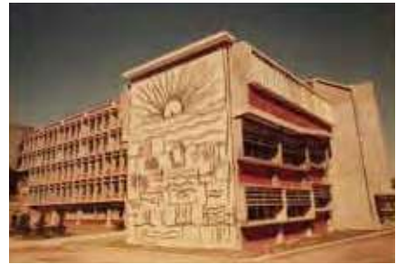
13. 完成直後のM棟鉄製レリーフ
