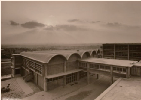
18. G30棟を東側から見る
