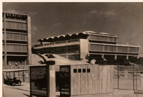
5. 西門から大学会館を見る
