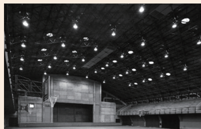
22. 鉄骨がダイヤモンドトラスによる大空間
