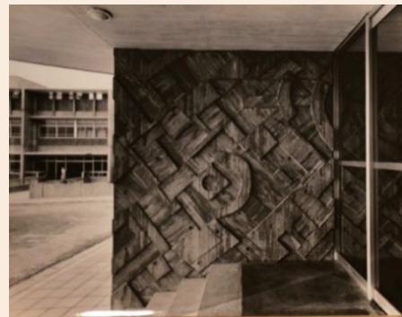
12. 第1研究室棟南の入り口(西側コンクリートレリーフ)
