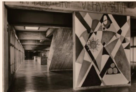
14. エントランスロビーからG棟奥を見る
