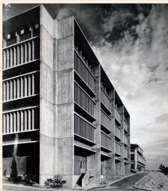
7. 図書館の西面と南面に取り付けられた縦ルーバー
