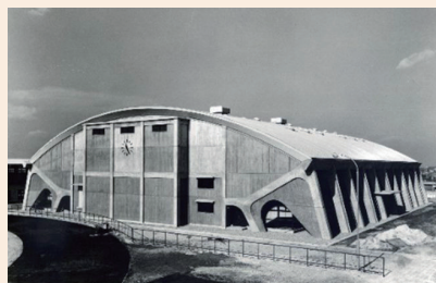
21. グラウンド側より見る体育館全景
